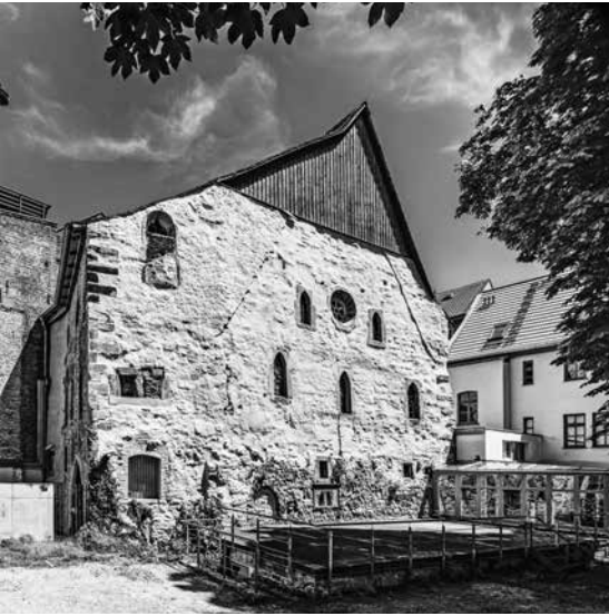
4 Bild der Erfurter Synagoge, Westmauer mit offenen und verbauten Fenstern. Die spitzbogigen Lanzettfenster und die Fensterrose stammen aus dem späten 13. Jahrhundert
